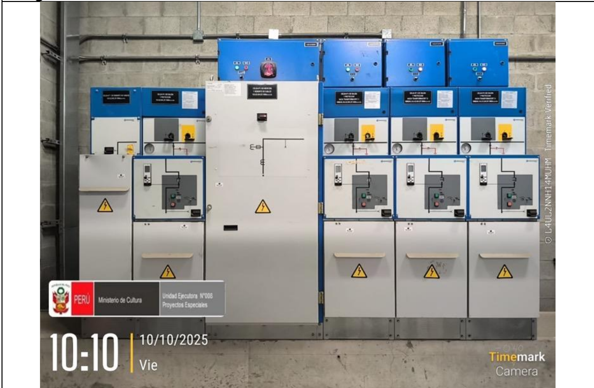
Imagen N° 02: Equipamiento de Sala de MT.
