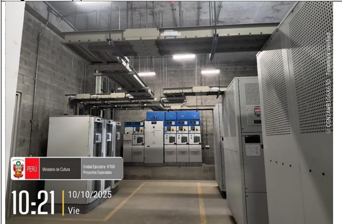
Imagen N° 03: 03 Transformadores de Voltaje
