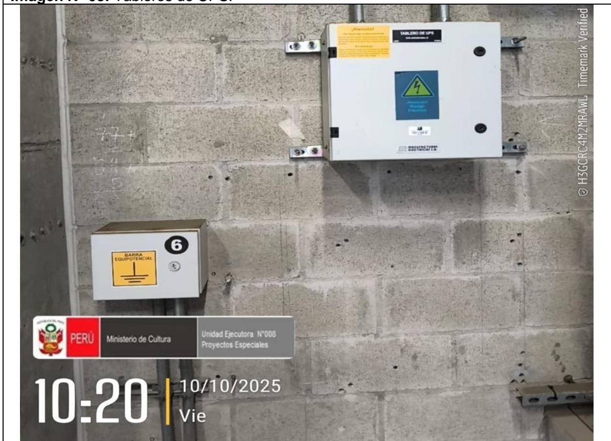
Imagen N° 09: Cajas de conexión de enlaces equipotenciales a tierra.
