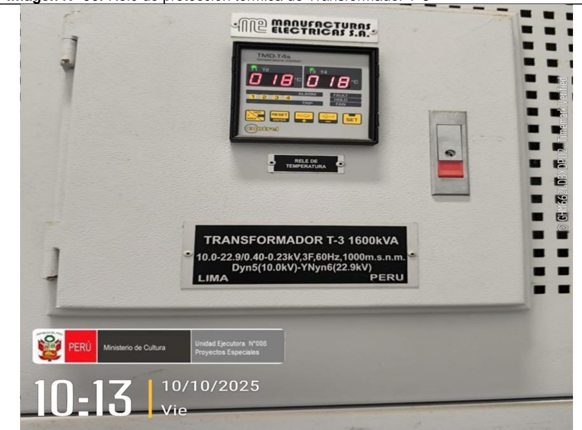
Imagen N° 06: Relé de protección térmica de Transformador T-3
