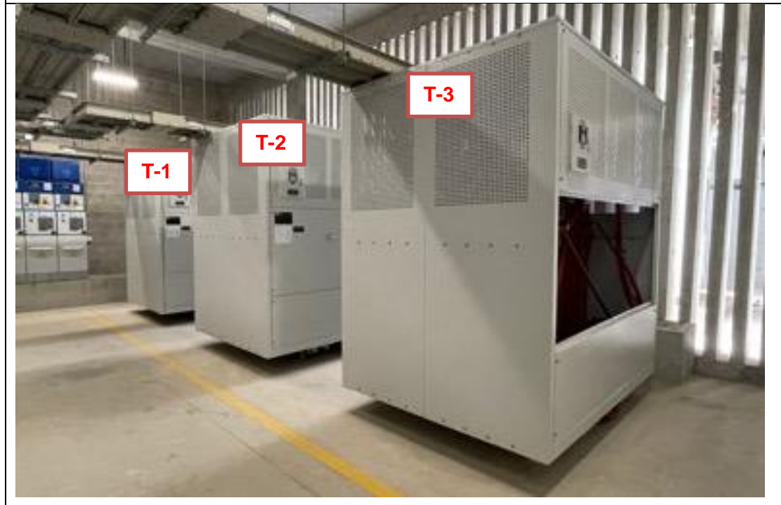
IMAGEN 02 “UBICACIÓN DE LOS 03 TRANSFORMADORES DE 1600KVA”.
