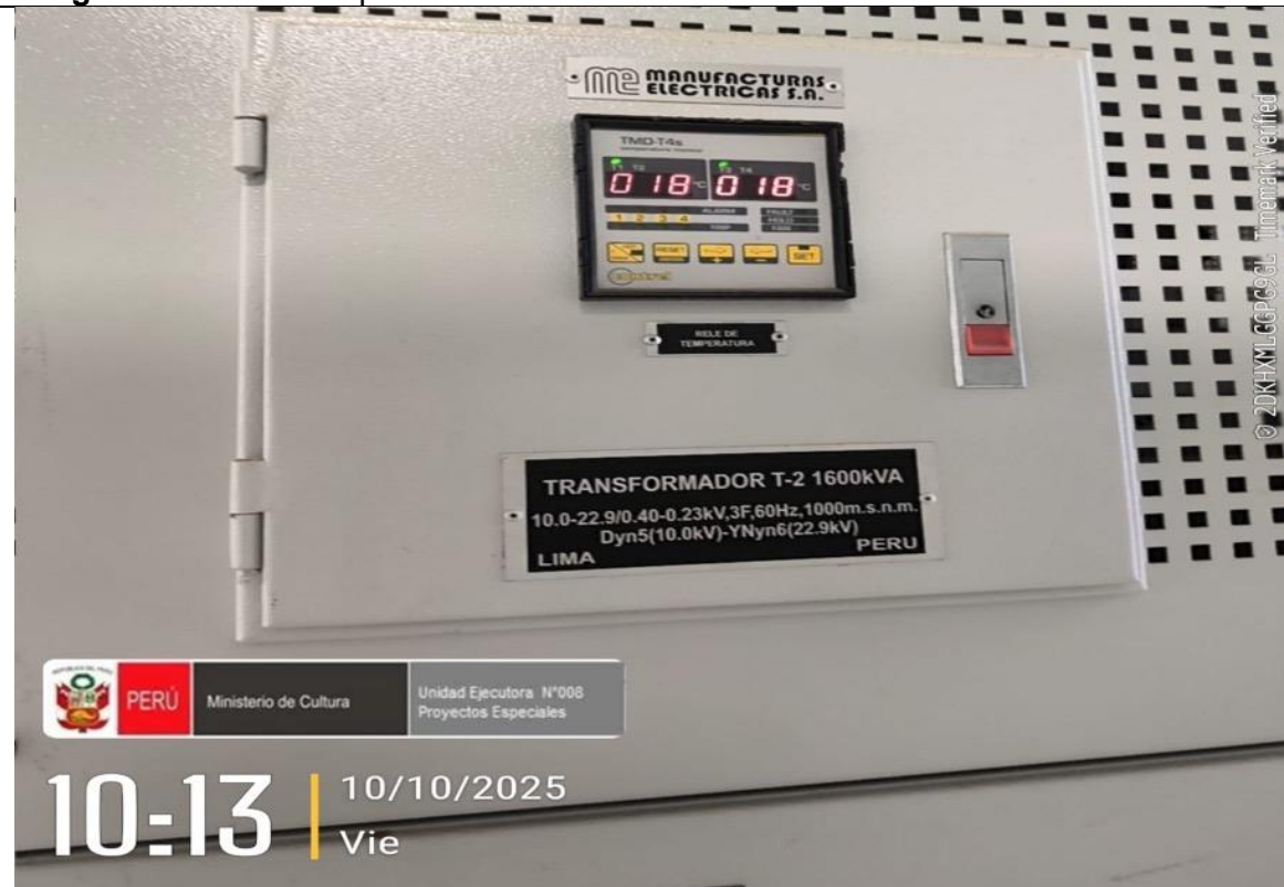
Imagen N° 06: Relé de protección térmica de Transformador T-3
