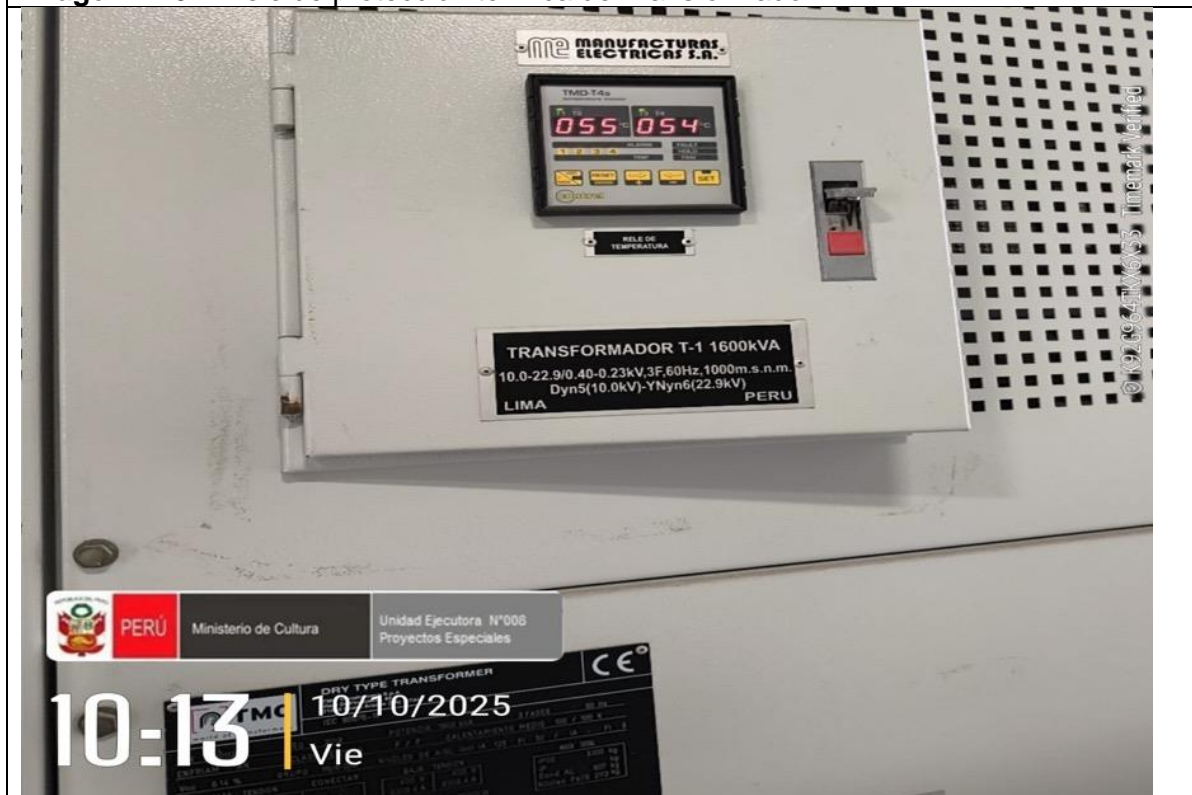
Imagen N° 04: Relé de protección térmica de Transformador T-1
